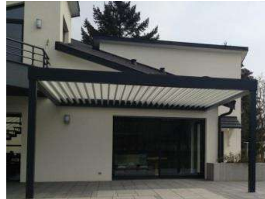
Instalación sobre fachada con 2 pilares
