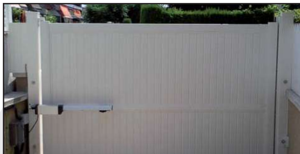
Concorde 90-A. Motorizacion
